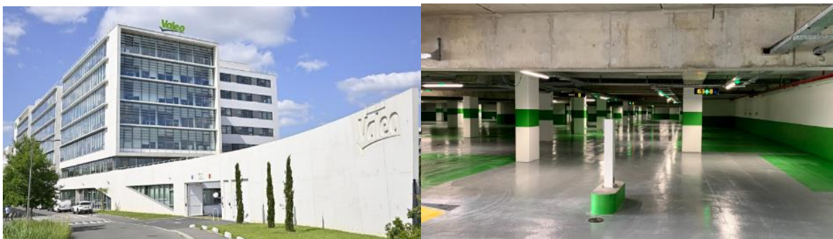
Figure 10 : Bâtiment Valeo VMTC Créteil – Parking R-1
